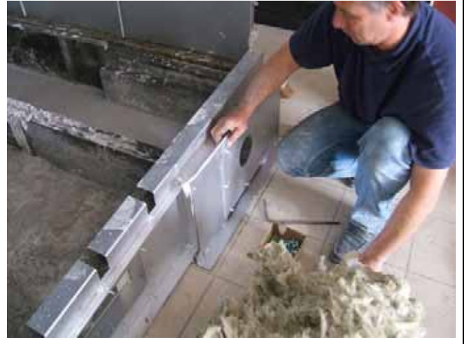
Positionner et boulonner la plaque avant du foyer
